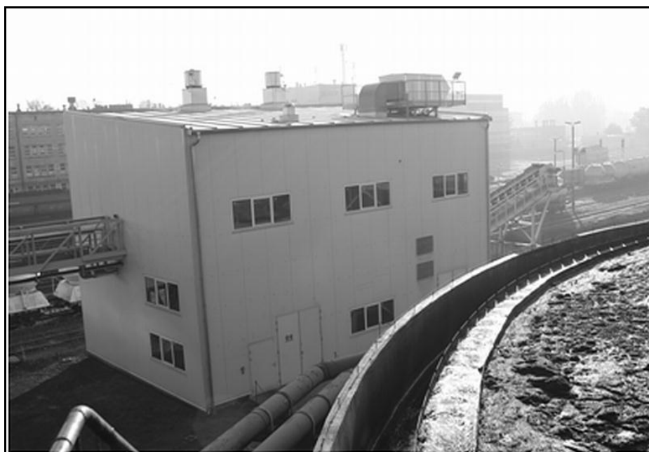
Rys.5. Widok budynku instalacji z zagęszczacza promieniowego Dorra 455 [4]
